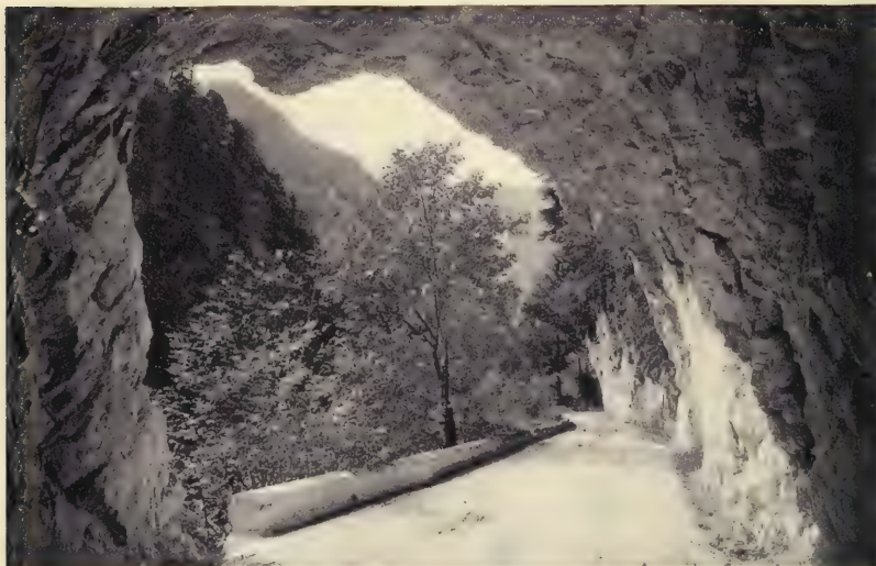
Tunnel sur la route de la Grande Chartreuse.
